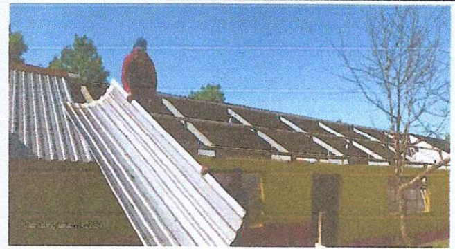
LA IMAGEN MUESTRA LA DESINTALACION DEL TECHADO POR LA REPACION DE MURO DE CONTENCIÓN
