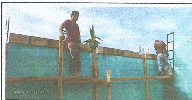
CORONACION DE MURO DE CONTENCIÓN CON BLOCK
