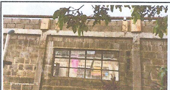
EN ESTA IMAGEN MUESTRA LAS CULUMNAS REFORZANRTES DEL MURO DE CONTENCIÓN
